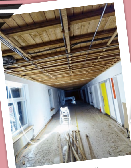
Ganz am Anfang der Umbauarbeiten.
