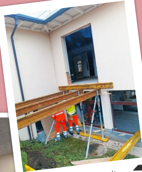
Einbau des Lifts an der Nordfassade.
