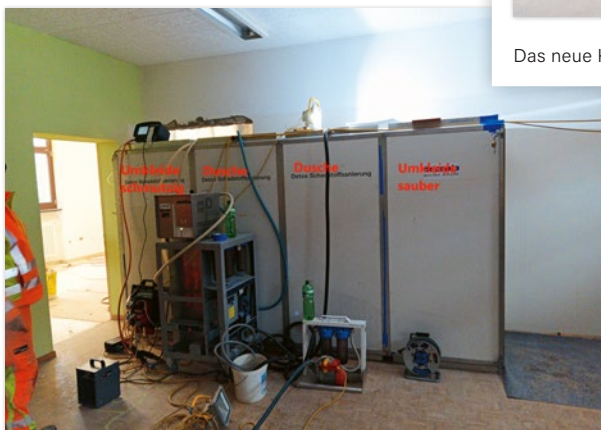
Rückbau Asbest: Sicherheitsschleuse für die Arbeiter.
