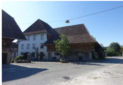
Fahrstrasse 15 (alte Mühle)
